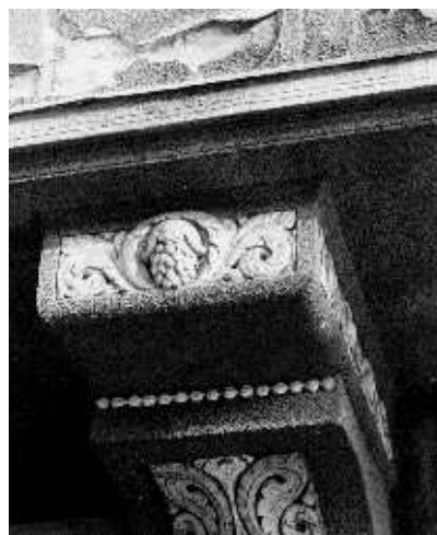
Ozdobne kroksztyny z motywem winnego grona na elewacji kamienicy przy ul. Sikorskiego 52, ok. 1920. Fot. Mirosław Kuleba
